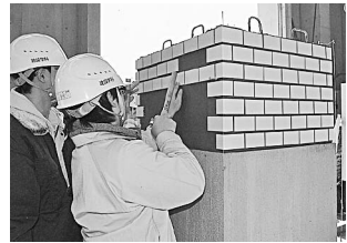
③タイル張り
