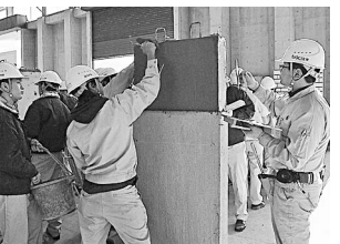
②下地コンクリートへのモルタル塗布
